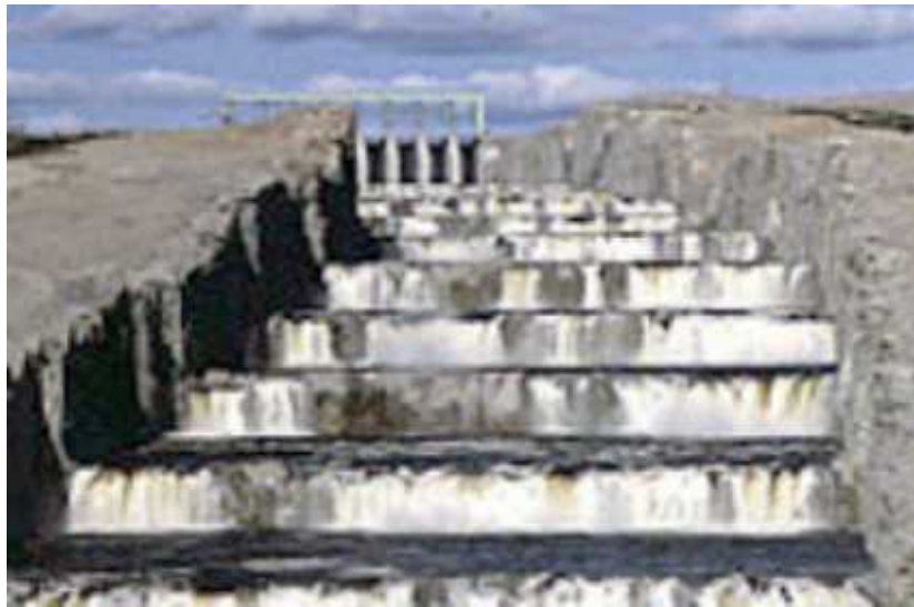
Évacuateur de crue du complexe Robert Bourassa
